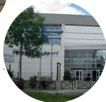
Travaux Espace du sport ➤ 200 000 €
