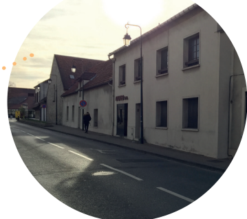
Construction du conservatoire ➤ 9 M€
